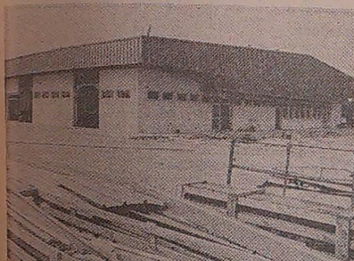
La terminal provisional de viajeros, que luego será de carga, está terminada en su aspecto exterior. En el interior faltan todavía muchos aspectos por concluir. (Foto EDUARDO).
